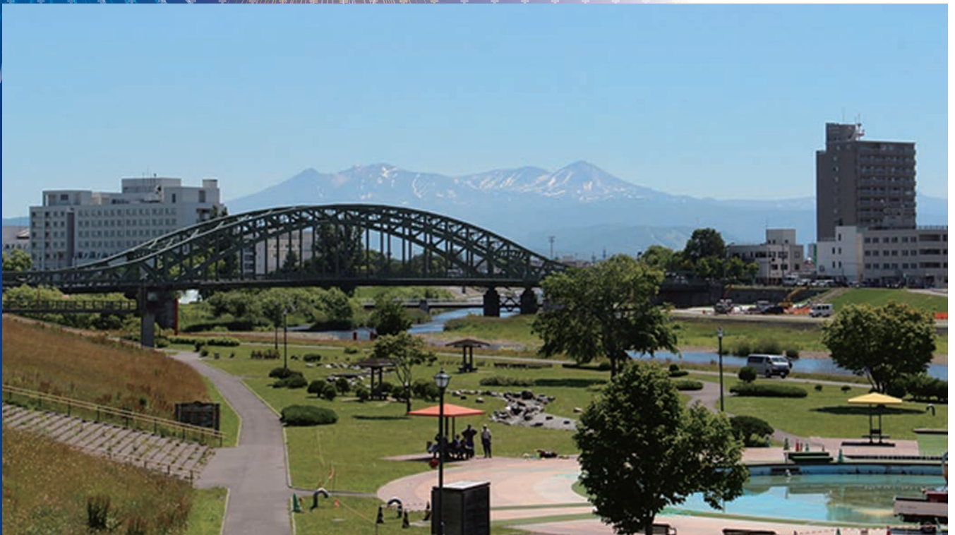
新橋から見た旭橋
