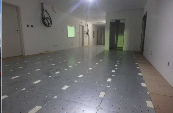
(右側)1階部分の施行状況
