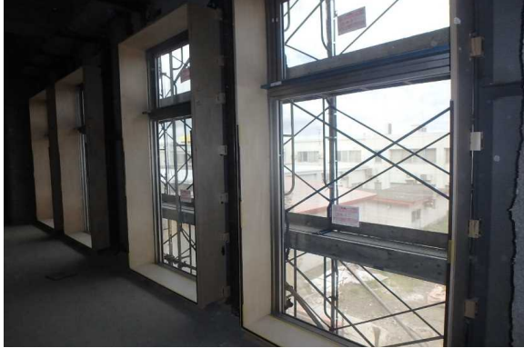
(左側)2階、鋼製建具・額縁取付の状況
