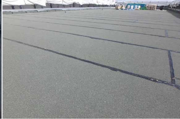
(右側)屋上防水工事の様子
