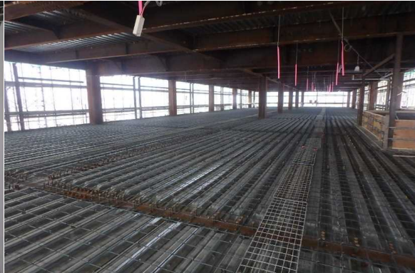
(右側)4階床スラブ鉄筋の組立(完了)
