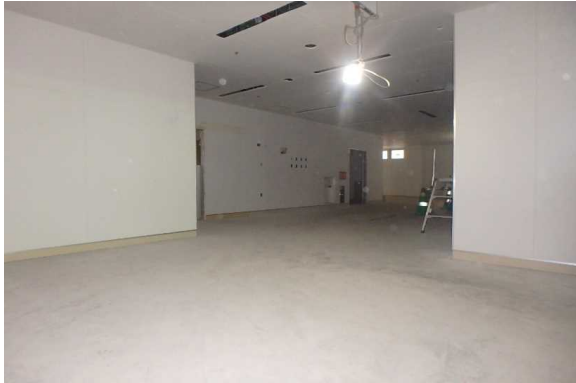
(左側)1F救急エリアの内装状況
