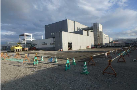
(左側)6月の工事外観
