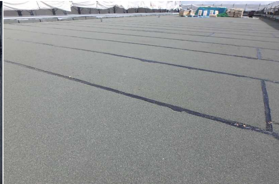
(右側)屋上防水工事の様子
