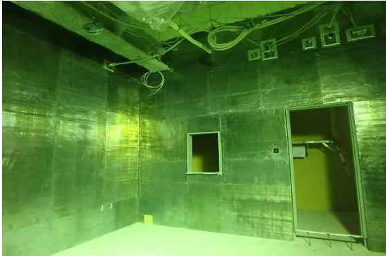
(左側)撮影室に鉛板を取り付けています。
