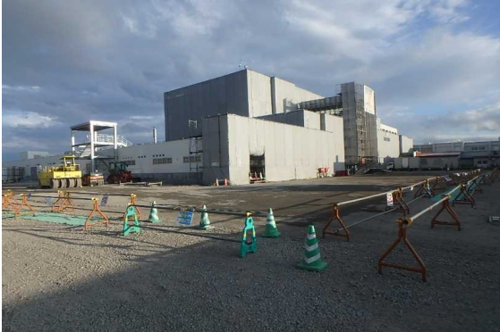
(左側)6月の工事外観
