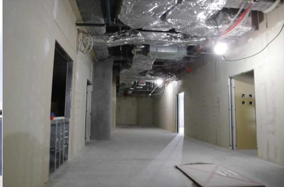
(右側)1階廊下の状況
