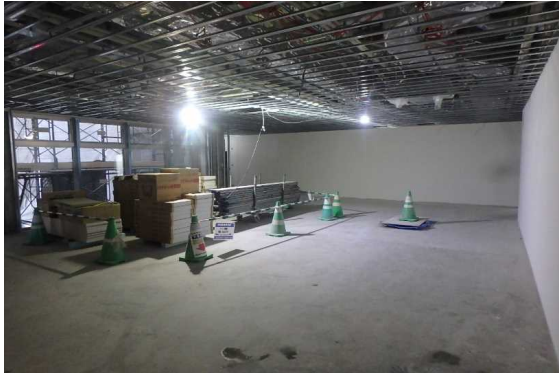
(左側)正面入口(ホスピタルモール)の作業状況
