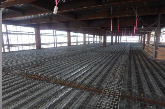
(右側)4階床スラブ鉄筋の組立(完了)
