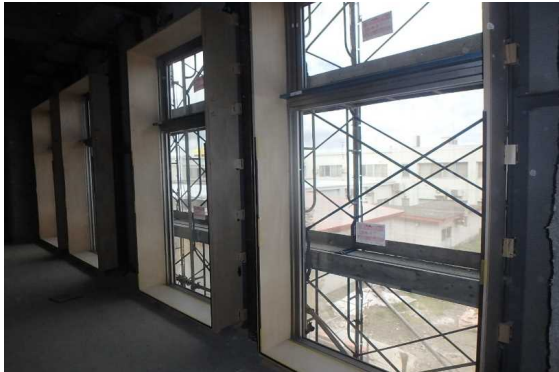
(左側)2階、鋼製建具・額縁取付の状況
