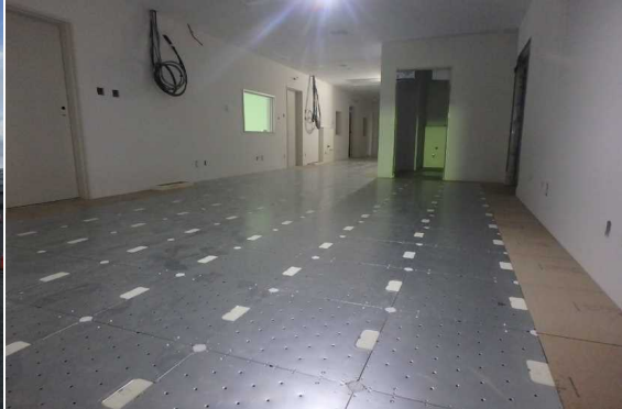
(右側)1階部分の施行状況
