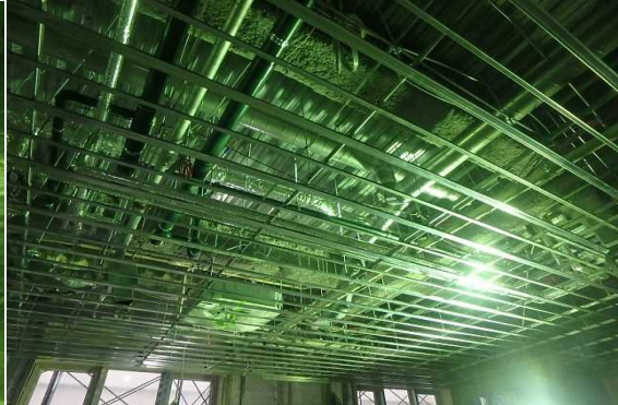
(右側)1階天井の組立てをおこなっています。
