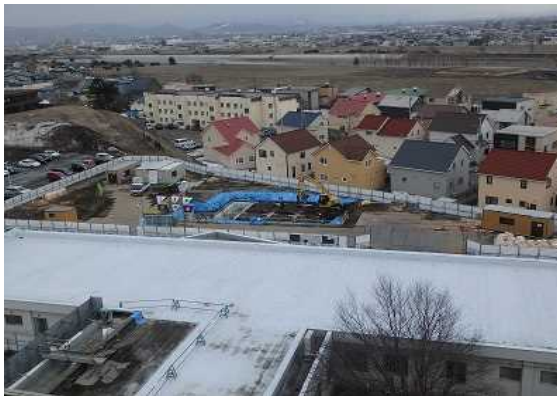
受水槽、液酸ポンプ棟(中央奥)の建設が始まりました
