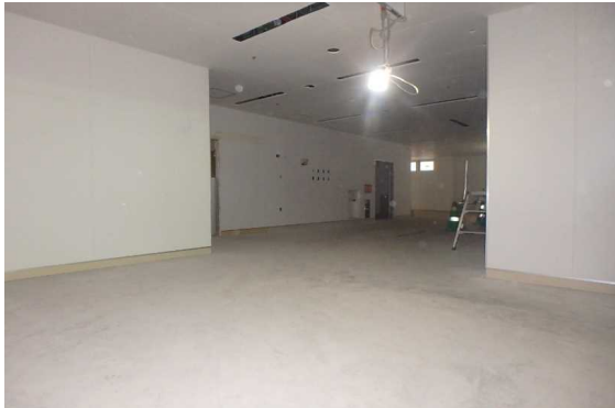
(左側)1F救急エリアの内装状況
