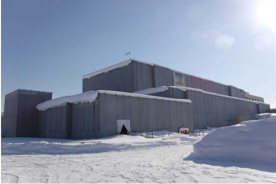
(左側)2月の工事外観
