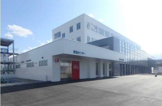
(左側)9月の工事外観
