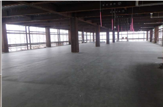
(右側)4階床スラブコンクリート打設(完了)
